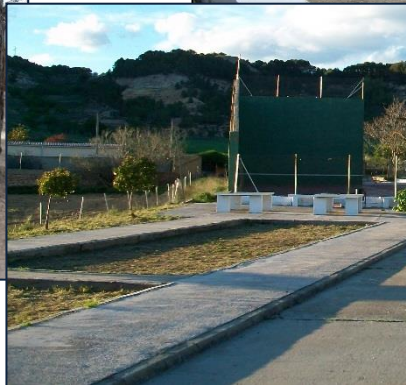
Construcción de 2 mesas de Ping-pong y 2 pistas de petanca
